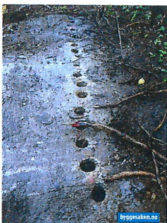
Sømboring med grovhull.
