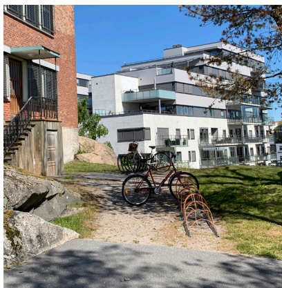
Sykkelparkering ved A-bygget
