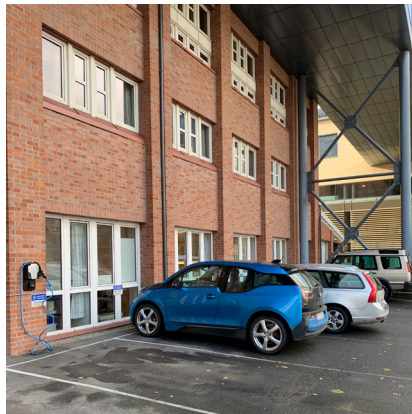
Parkering foran H-bygget
