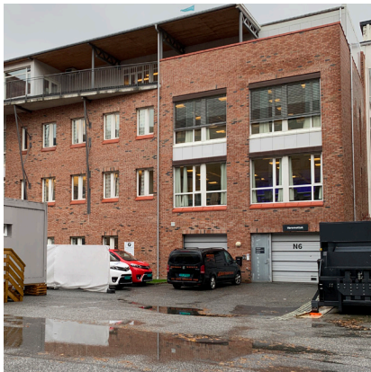
Parkering foran N2-bygget
