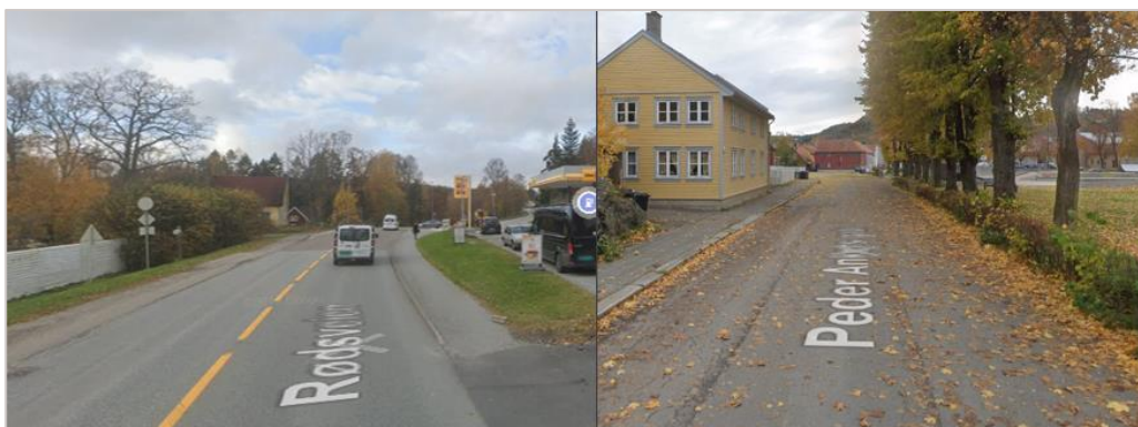
Figur 7 – Gatebilder fra Rødsveien ved Uno X bensinstasjon og Peder Ankers vei (ved nr. 5), der deler av strekningen har veldig smalt fortau (foto: google.streetview.no).
