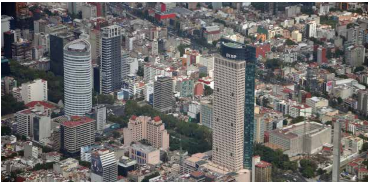
Torre Mayor er en av de høyeste bygningene i Latin-Amerika og ligger i Mexico City, den største byen i verden hvor spansk er offisielt språk. ID 26055837 © Enrique Gomez Tamez
