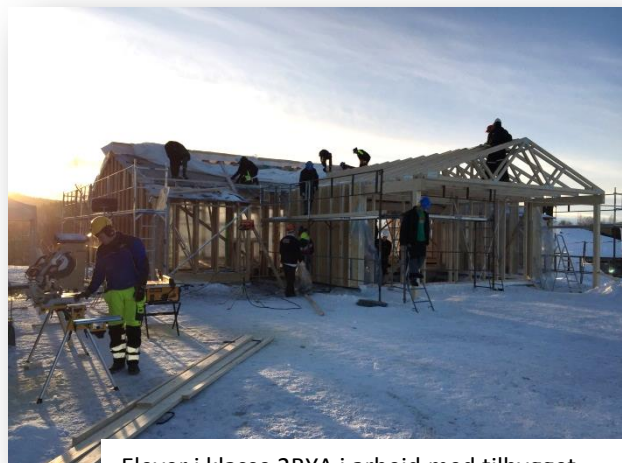
Elever i klasse 2BYA i arbeid med tilbygget. Foto: Ståle Tranås, Olav Duun vgs.
